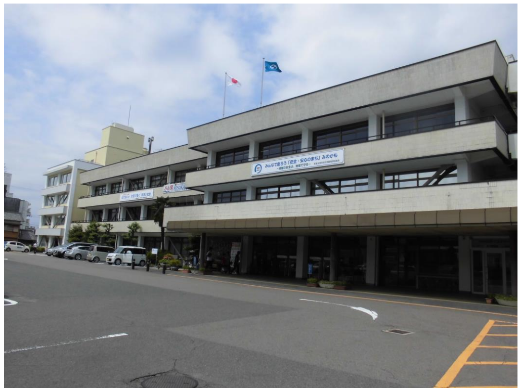
図 1.1.1 研究対象施設の外觀写真
