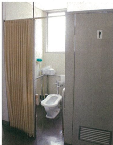
簡易間仕切りの身障者用トイレ
