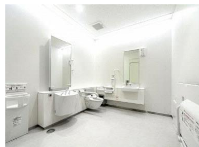
多目的トイレの例
