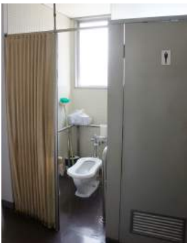
簡易間仕切りの身障者用トイレ
