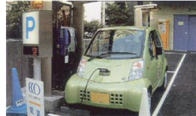
急速EV充電器の例
