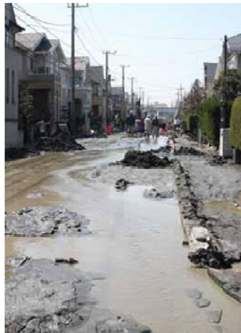
写真 1-1 住宅地の噴砂の状況
