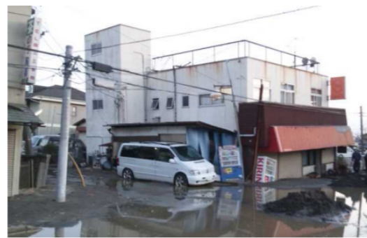
写真 1-3 建物の傾斜被害
