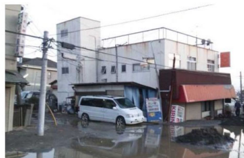
写真 1-3 建物の傾斜被害
