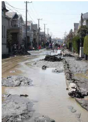
写真 1-1 住宅地の噴砂の状況
