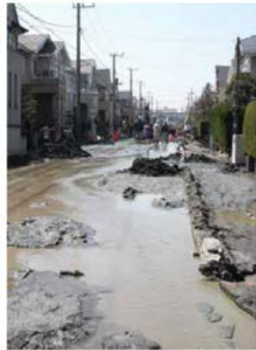
写真 1-1 住宅地の噴砂の状況
