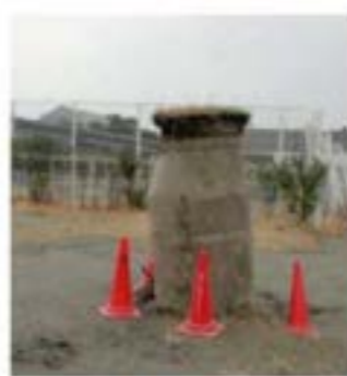
写真 1-2 地下埋設物の浮き上がり
