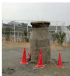
写真 1-2 地下埋設物の浮き上がり
