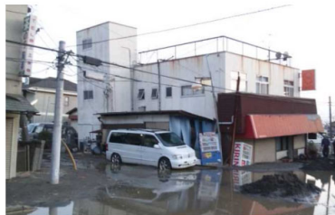
写真 1-3 建物の傾斜被害
