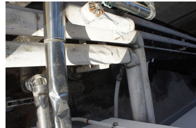
本館屋上設備配管の凹み
